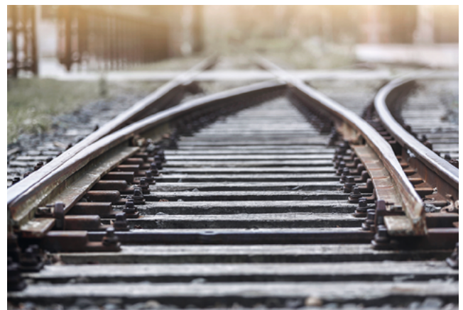
Bahnanbindung über neue Bayernhafen Infrastruktur in Plattling
