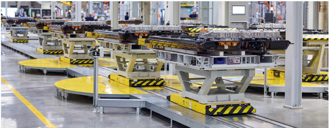
Gen6-Hochvoltbatterie-Fertigung im BMW Group Werk Debrecen
