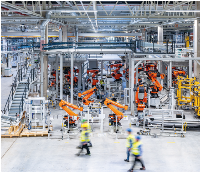
Die Produktionshalle füllt sich mit mehr und mehr Anlagen
