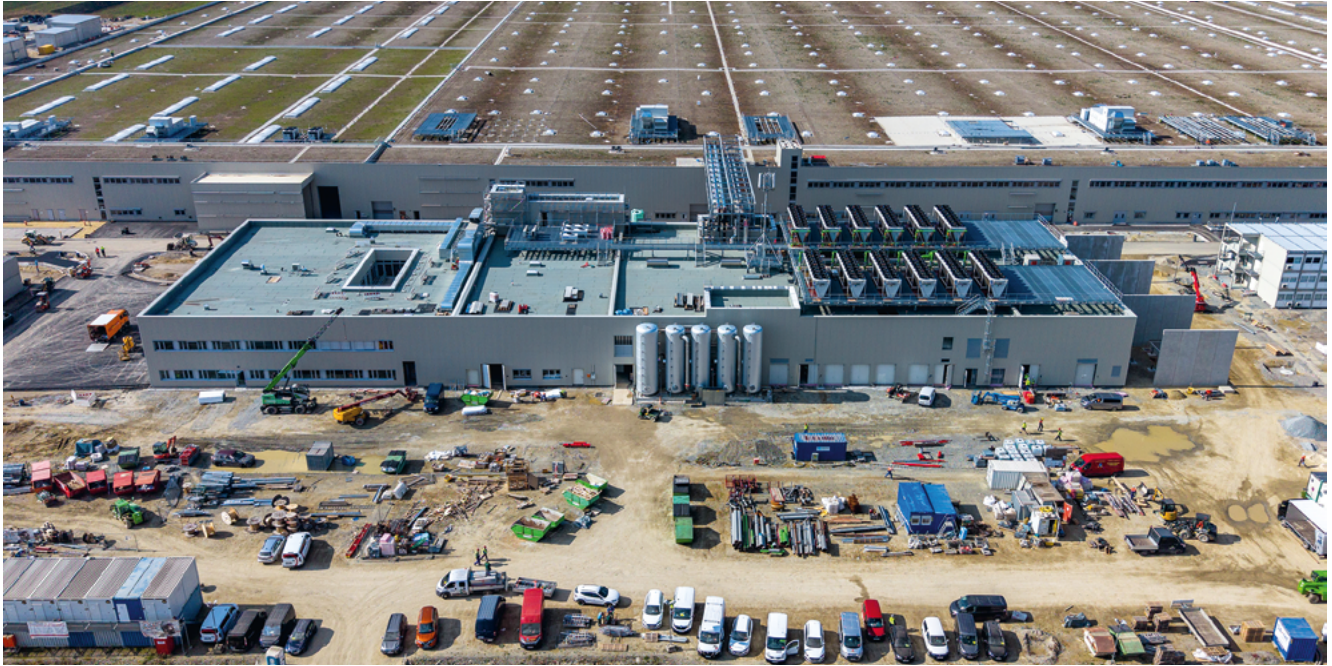
Luftaufnahme des Montagewerks für Hochvoltbatterien Irlbach-Straßkirchen Ende September mit Energiezentrale und Feuerwehrgebäude im Vordergrund
