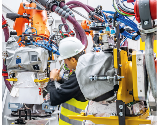
Anlagenaufbau in der künftigen Produktionshalle im Werk Irlbach-Straßkirchen
