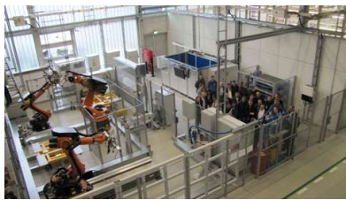
Bild 01: Vertreter der Projektpartner von DC-INDUSTRIE2 besichtigen die Gleichstrom-Testanlage im Karosseriebau des BMW Group Werks Dingolfing.
